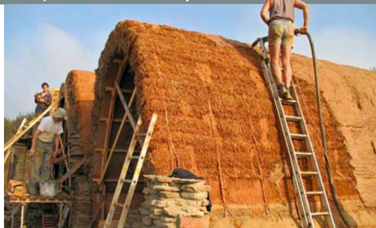
realizacja niskobudżetowych domów ze słomy i gliny, Tamera, Portugalia, proj.: prof. Gernot Minke , 2007
